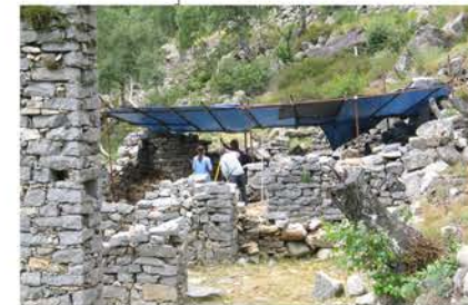
Tre momenti del recupero dell'Opificio: dopo la deforestazione, durante i restauri, durante gli scavi archeologici.
