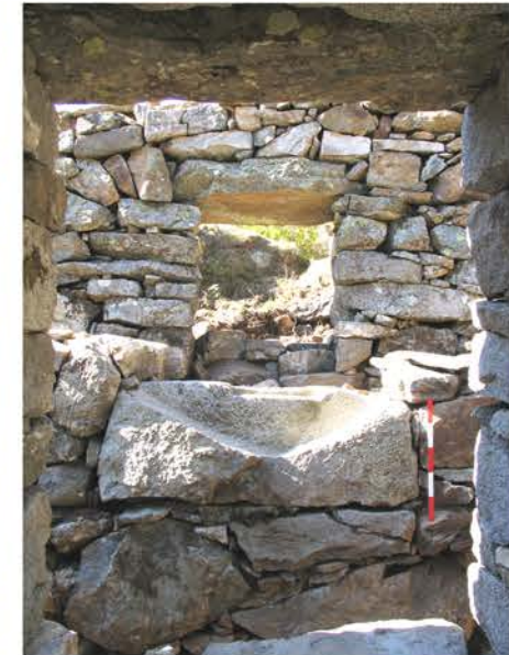
Muro inglobante uno dei supporti lapidei sagomati della ruota idraulica, prima e dopo il restauro.
