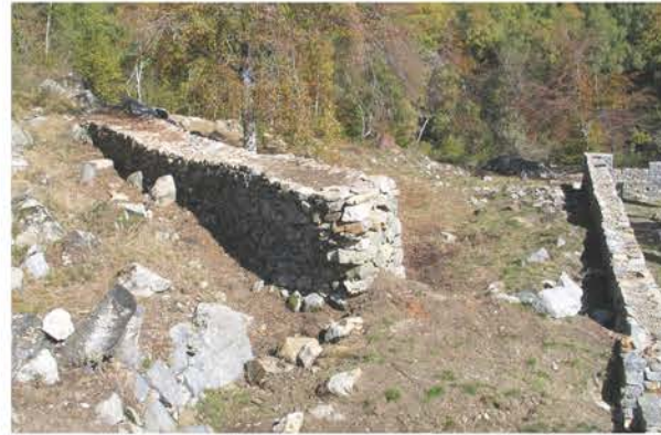
Rampa di carreggio con ai piedi la zona in cui avveniva la prima cernita del minerale grezzo.
