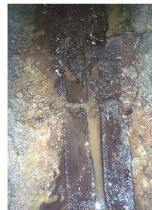
Tavole lignee utilizzate per facilitare il trasporto del minerale, per caduta nel «canale di rolamento» o su vagoncini all'interno delle gallerie.
