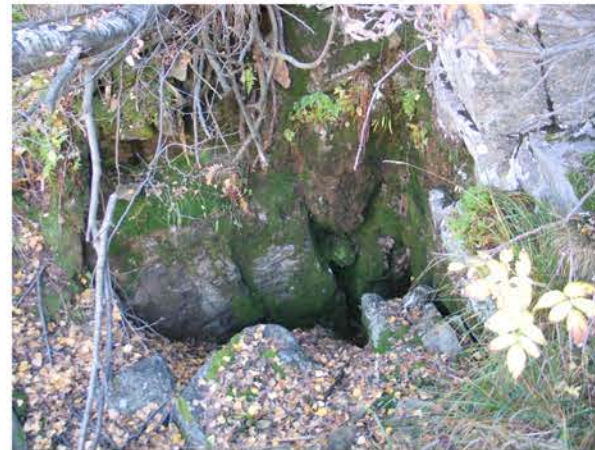
Ingresso ostruito del «ribasso».
